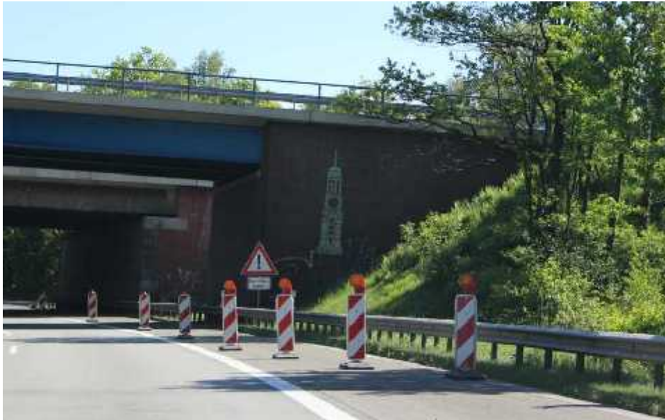
Autobahnbrücke mit Halbreliet (Wiedergabe des Hamburger Michel)
